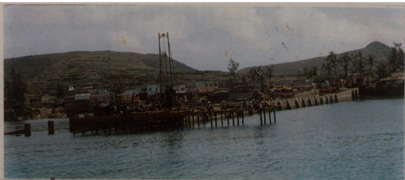
● Cảng cá Lý Sơn đang được thi công (trên)
