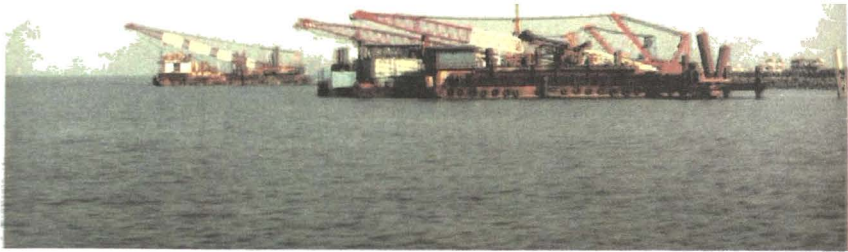
Tập kết phương tiện thi công gói thầu 5B
