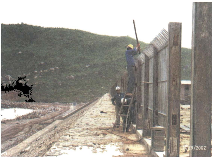
hi công tường rào gói thầu EPC 3 (Khu bể chứa sản phẩm)
