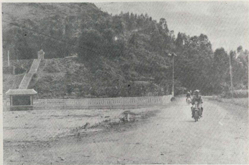
Đường giao thông trong xã đã được mở rộng và nâng cấp
